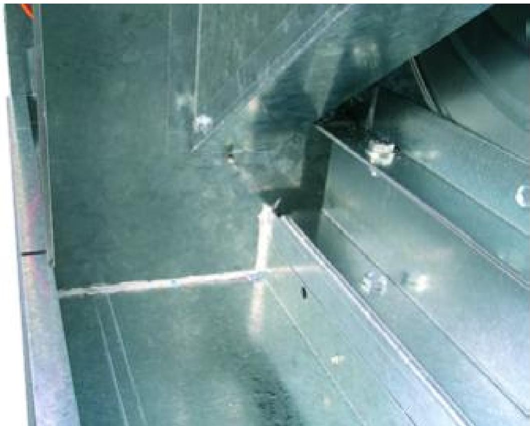
**Caja estanca que evita la salida de condensados**
