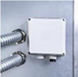
**Caja de conexiones actuadores (Hatch)**
